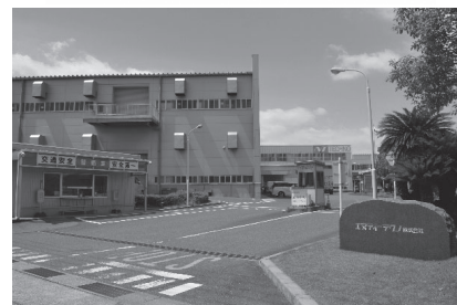
エヌティーテクノ本社 外観
