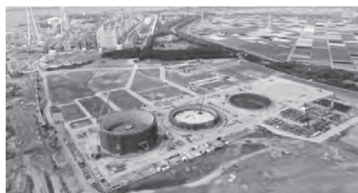
▲ 商用運転に向けた建設状況
