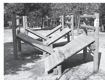
遊具設置工事
