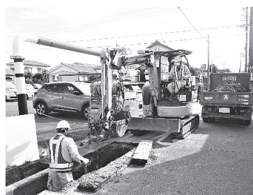
道路側溝工事
