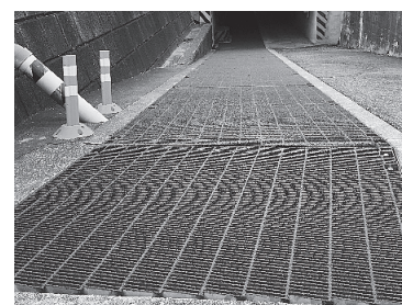
グレーチングに吹付
