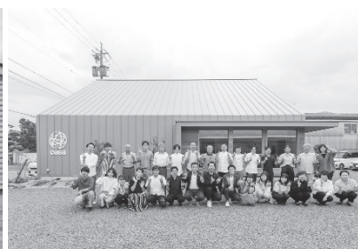
建築家と建てる家 ▲ casa MIKAWA MINAMI (西尾市)
